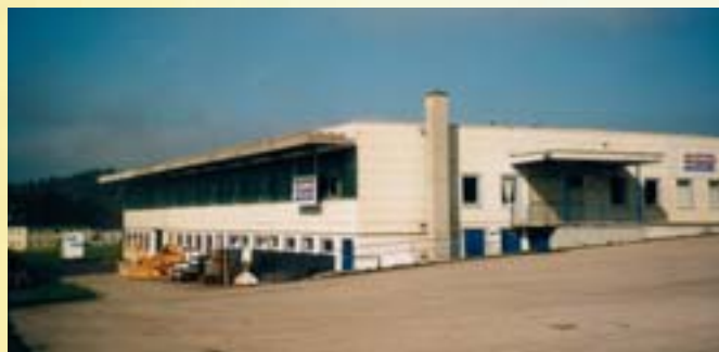
Fábrica de GASOKOL en Dimbach
